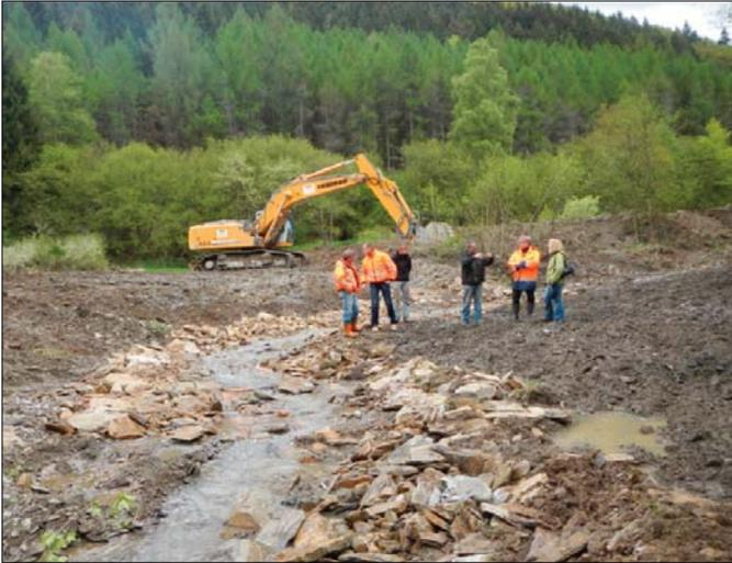
Auch der Rückbau des Sedimentationsbeckens am Gierbach erfolgte in Abstimmung mit den Wasserbehörden und weiteren Beteiligten. Die Steinschüttung verhindert, dass Feinsedimente vom Uferbereichen in den Bach gespült werden.
