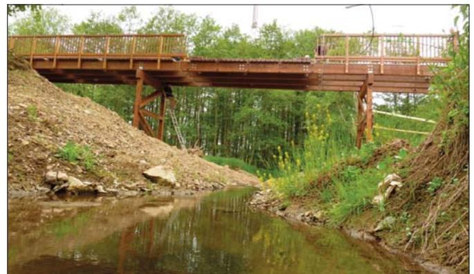
Die 30 Meter lange Brücke über den Helingsbach wurde mit einem Kran gesetzt
